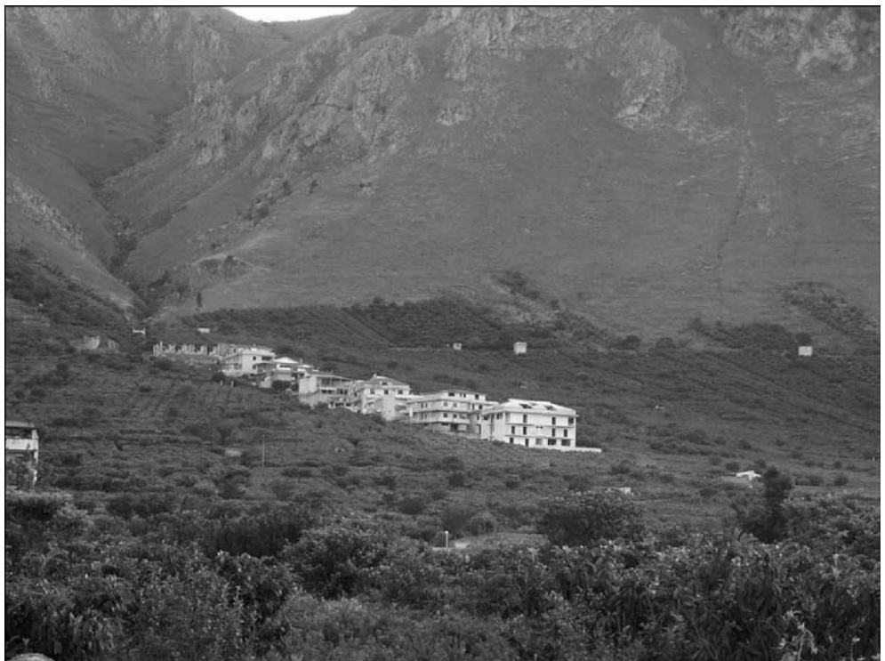
Figure 2 : Constructions illégales dans les hauteurs de Ciaculli (2003)
