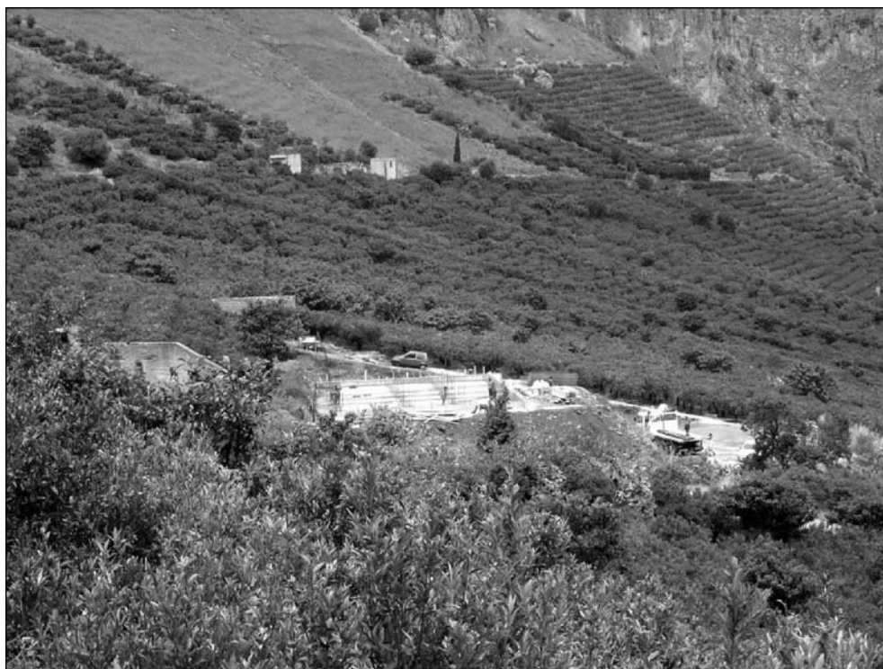
Figure 3 : Travaux de construction d'une habitation illégale à Ciaculli (2003)
