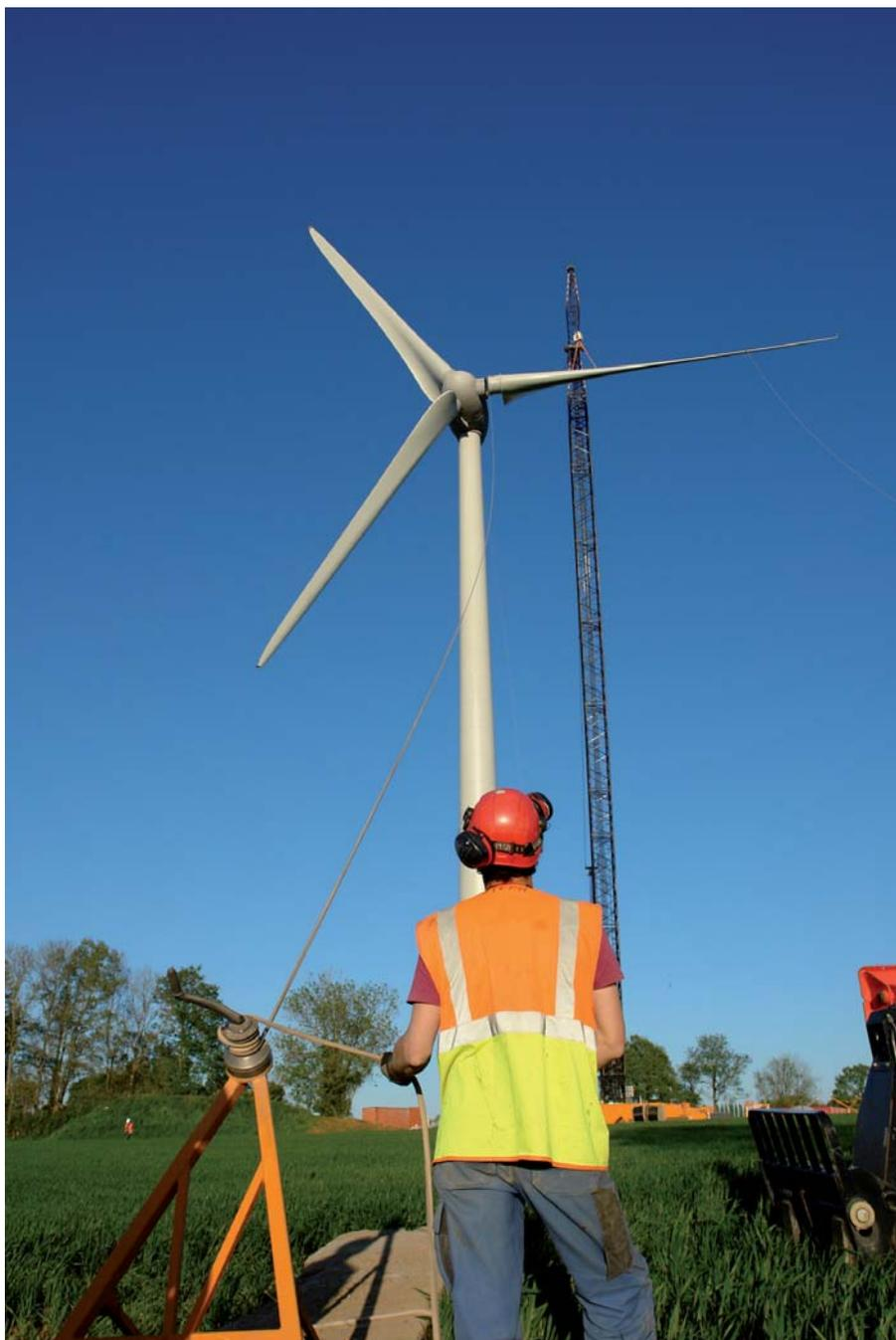
PHOTO 19 ■ Grutage d'une pale d'éolienne E101 Enercon (© Photo Olivier Martinet – Enercon).
