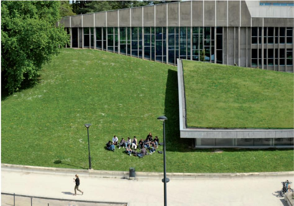
**Figure 1.2.** Toiture végétale à l'université de Nantes. Photo : Service Photo, université de Nantes.
